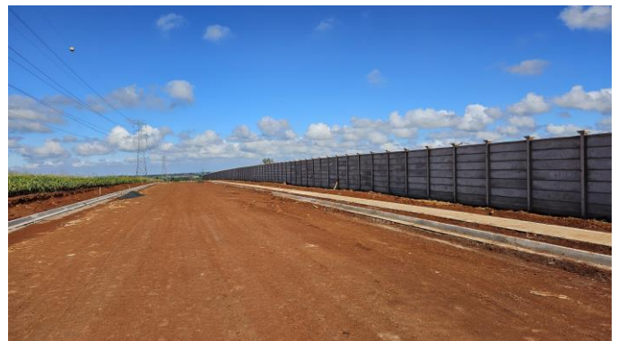
Fotografia atual da obra – Damha Fit I
