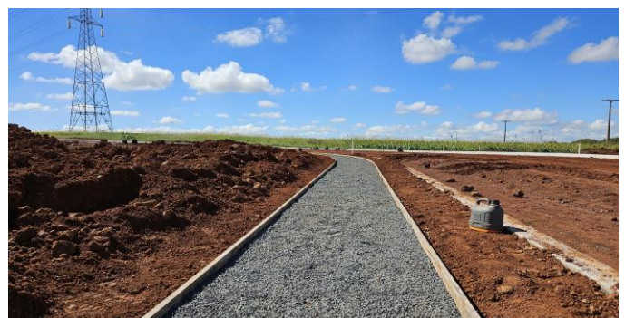
Fotografia atual da obra – Damha Fit I
