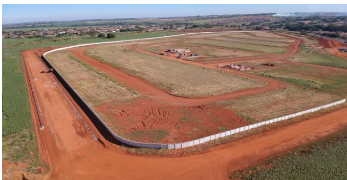
Fotografia atual da obra – Damha Fit I
