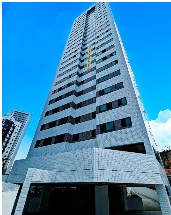
Fotografia atual da obra - Luar do Arraial
