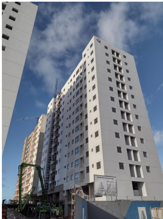
Fotografia atual da obra – Luar do Parque
