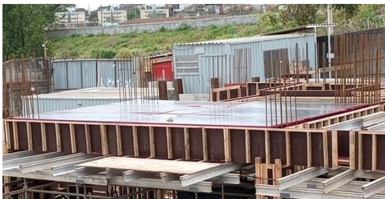
Fotografia atual da obra – Livus Parque Ecológico
