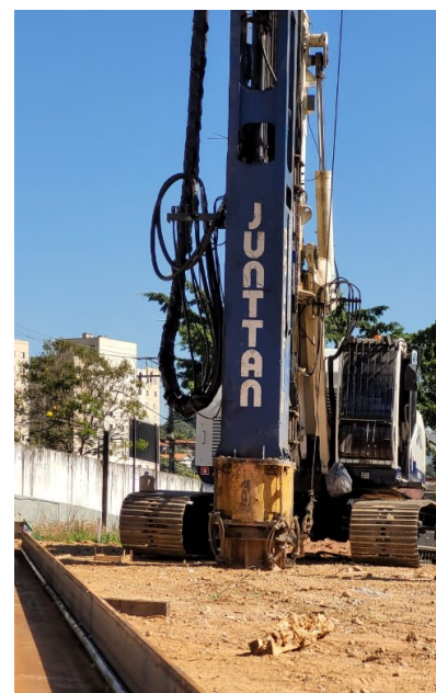
Fotografia atual da obra – Livus Butantã
